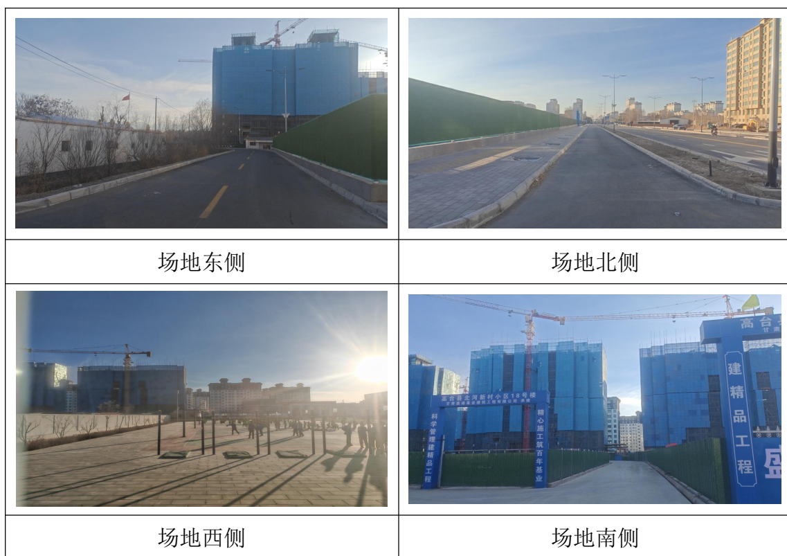
图5-2 地块访谈及现场踏勘情况
