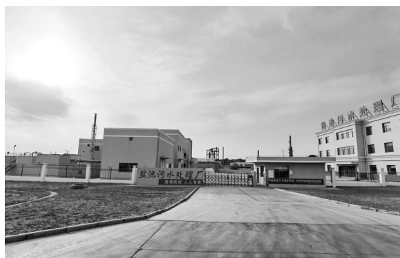
盐池工业园污水处理厂
