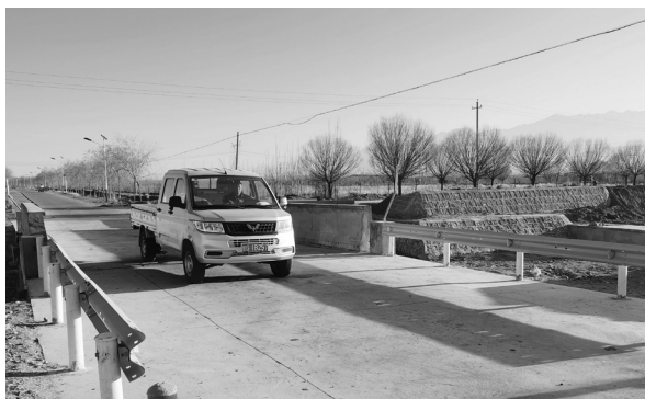
新建明水村、明永村、永进村车桥
