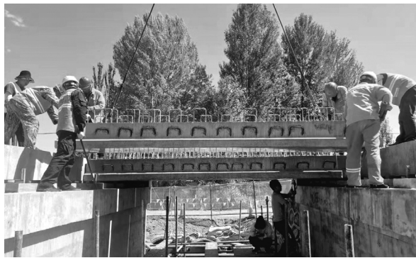
维修公路桥梁
