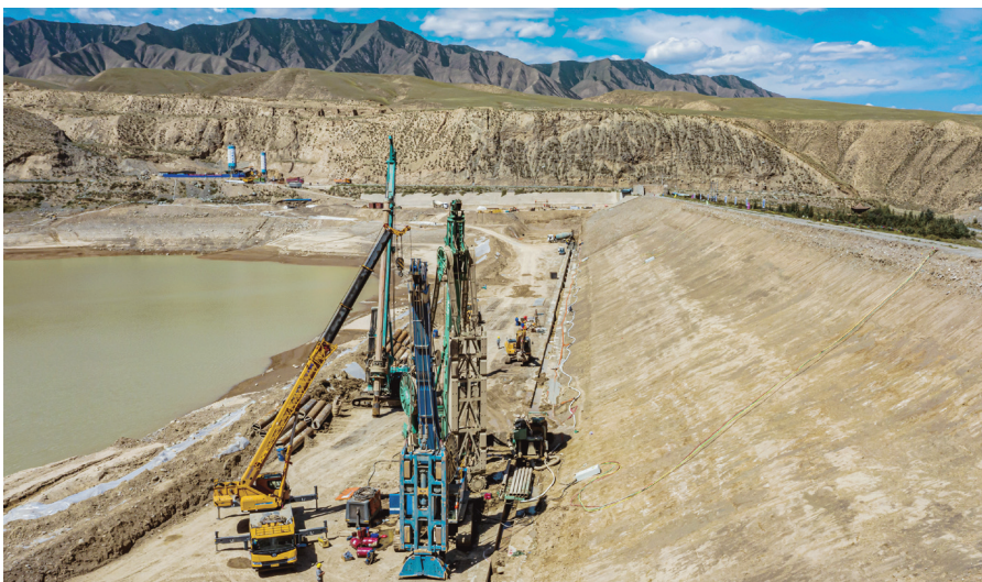
加强水库蓄水能力建设，建成塘坝29座、防洪堤坝74.4公里。2021年4月，摆浪河水库除险加固工程开工建设（周忠/摄影）
