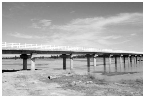
新建成的黑河大桥
