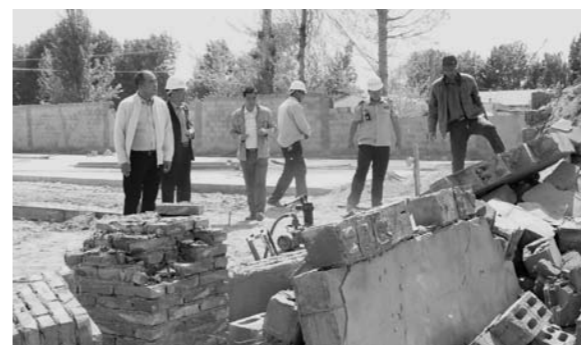
拆除违章建筑
