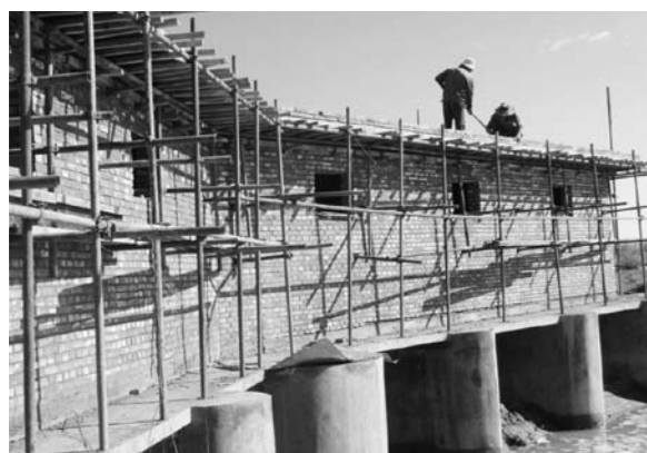
河西村杨家沟进泄水闸维修工程
